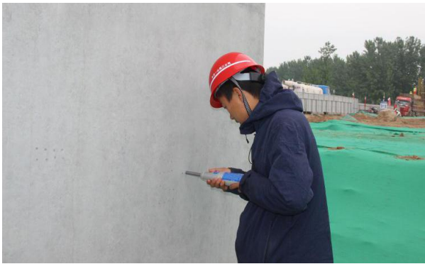
回弹检测墩柱混凝土强度
