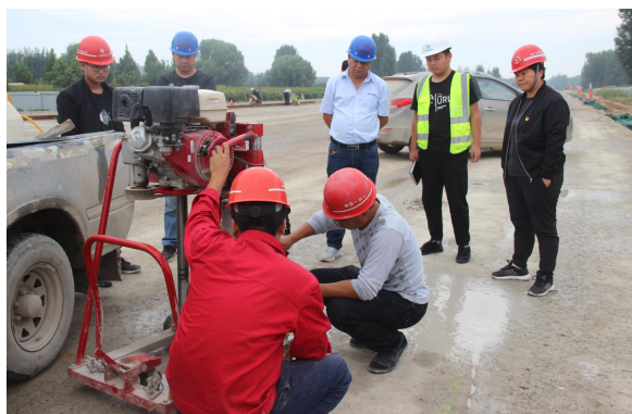
路面取芯质量检测
