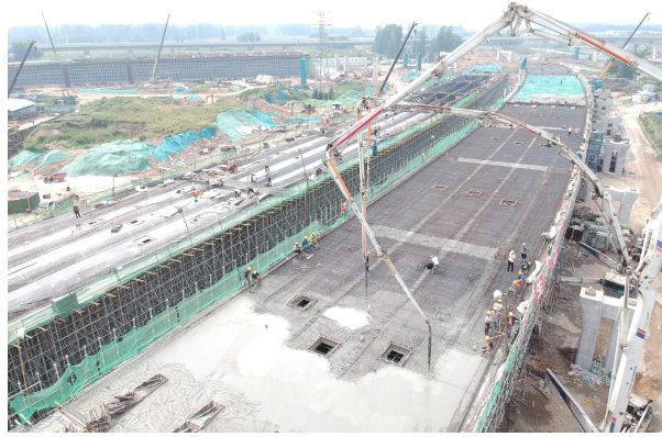
现浇箱梁浇筑
