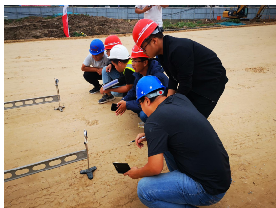
严格路基弯沉试验
