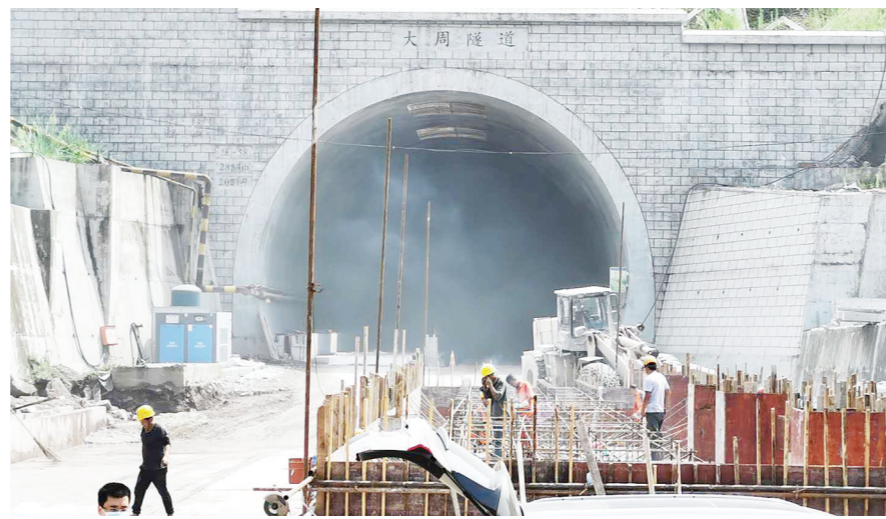
郑万高铁大周隧道
