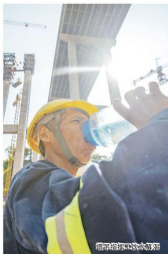
塔吊指挥员喷水降温
