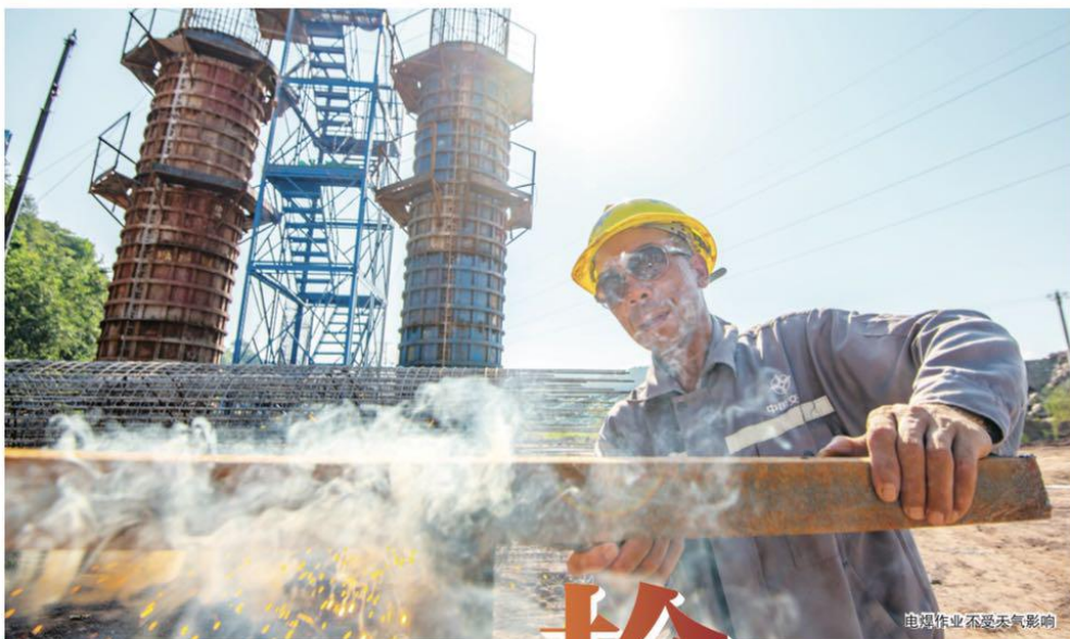
电焊作业不受天气影响
