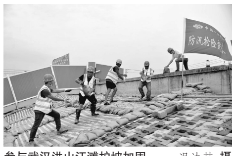
参与武汉洪山江滩护坡加固。 况达喆 摄
