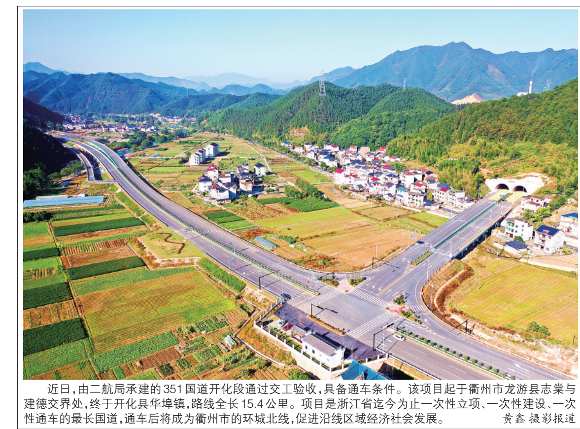
近日,由二航局承建的351国道开化段通过交工验收,具备通车条件。该项目起于衢州市龙游县志棠与建德交界处,终于开化县华埠镇,路线全长15.4公里。项目是浙江省迄今为止一次性立项、一次性建设、一次性通车的最长国道,通车后将作为衢州市的环城北路,促进沿线区域经济社会发展。 黄鑫 摄影报道
