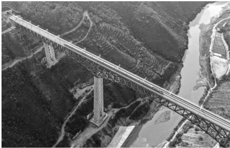
列车通过中铁四局承建的中老铁路元江特大桥。
